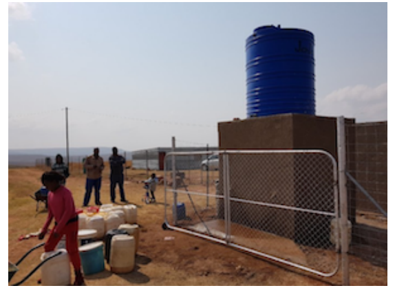
▲소볼로마을 샘물 취수 시설 설치
